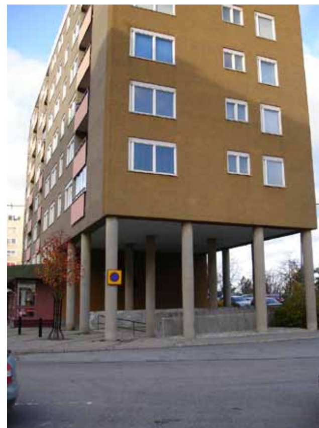
Gavelfasad stående på betongpelare.
