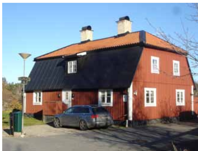
Till herrgårdarna hörde en mängd olika byggnader, här en lantarbetrarbostad från 1820-talet som tillhört Kummelnäs säteri i norra Boo. Huset har trots sin ursprungliga anspråkslösa funktion en förvånansvärt ståndsmässig utformning med ett valmat mansardtak, en herrgårdsmässig variant av det brutna taket. Själva herrgården har ersatts av nya hus.
