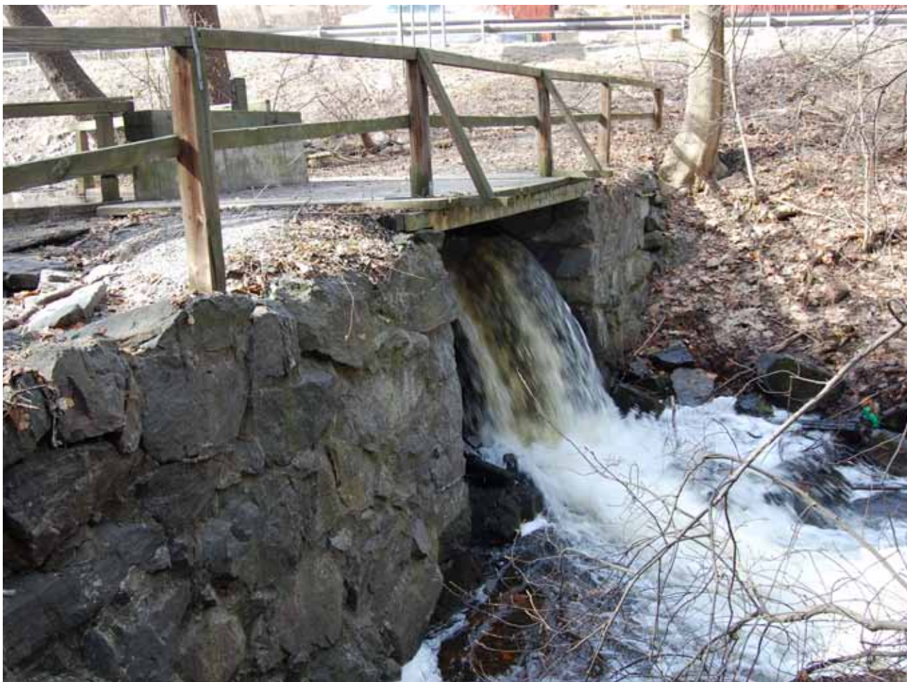
Fördämning med forsande vatten.
