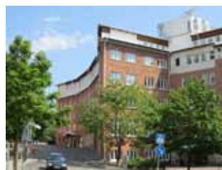
F.D. RYLANDER & RUDOLPHS ELEKTROTEKNISKA FABRIK, "KOLSPETSEN", HENRIKS-BORG
