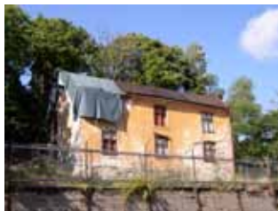
Chefsbostad från 1830-talet, Finnbodas äldsta byggnad. Byggs ursprungligen för chefen för det beckbruk som låg på platsen innan varvet etablerades på 1870-talet. Blev bostad för varvs-
