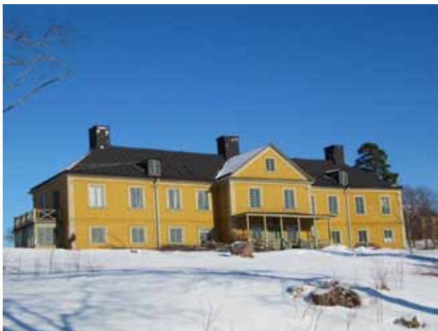
1720-talsherrgården är uppbyggd enligt det karolinska idealet med en låg ekonomivåning och en högre huvudvåning med större fönster. Huset är timrat men panelbeklätt med detaljer av 1800-talstyp.
