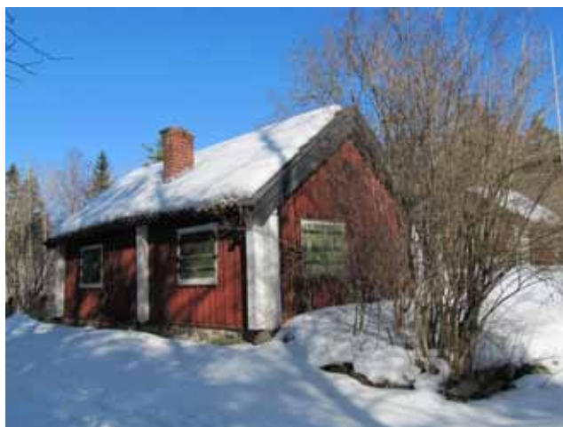
Klockarbostaden Snörom. De utstickande knutlådorna avslöjar en liggtimmerstomme och skorstenens läge långt ner på takfallet vittnar om en ålderdomlig takkonstruktion med längsgående åsar. Den låga grunden av natursten hör till äldre jordbruksbebyggelse före 1800-talets mitt.
