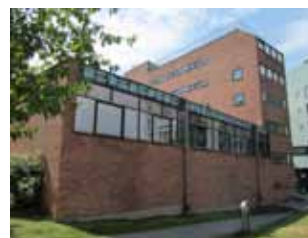
"GOMANHUSET", F.D. KF:S LIVSMEDELSLABORATORIUM
